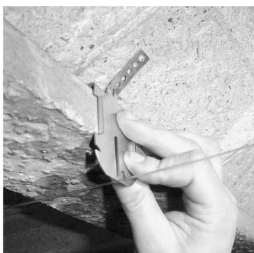
**1.** Positionner la suspente PHAR sur le talon de la poutrelle en pliant la languette en sous-face de l'entrevous.
