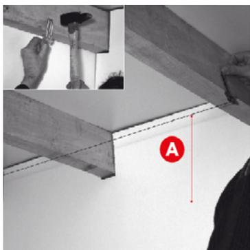
1. Après le traçage de la hauteur de l'ossature (A), repérer le niveau des suspentes par rapport au sol, pré-positionner les avec les griffes ou les trous oblongs et les fixer ensuite avec les vis.
