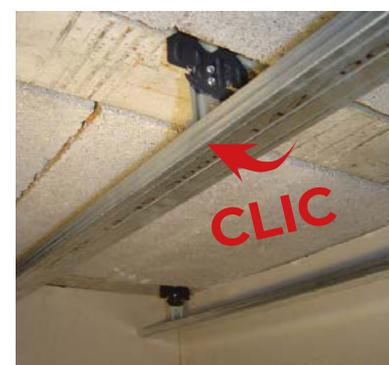
3. Clipser les fourrures SPP sur les suspentes PAI en engageant une aile dans la fente horizontale puis faire pivoter jusqu'au CLIC.
