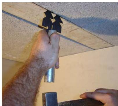
1. Positionner la suspenste entre la poutrelle et le hourdis béton, griffes côté hourdis.
