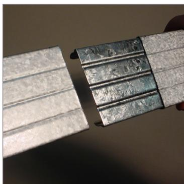
**1.** Emboîter le raccord dans l'ouverture d'une des fourrures.
