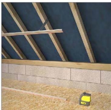
1. Prendre l'aplomb sur l'angle bas de la fourrure horizontale puis reporter le point et fixer une lisse clip au sol.
