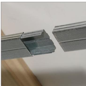
**1.** Disposer le raccord dans le sens inverse de l'ouverture des fourrures.
