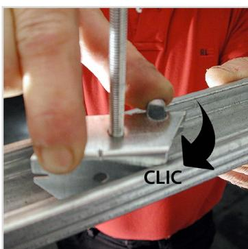
**1.** Après avoir vissé la tige filetée dans le cavalier, faites le pivoter dans la fourrure jusqu'au clic en vous aidant des languettes.
